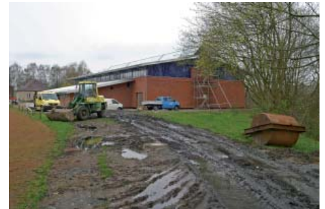
Baustelle der / Zufahrt zur Baustelle der Turnhalle
