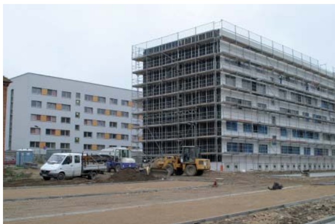
Containerschiff Wohnheim 11 wird komplett Grundinstandgesetzt
