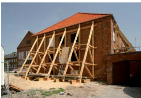
Bevor's zusammenfällt: Das Heizhaus wird abgestützt.
